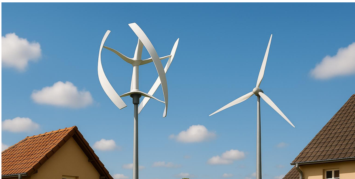
Rysunek 8. Przykłady małych turbin wiatrowych. Po lewej z pionową osią obrotu, po prawej z poziomą osią obrotu,
