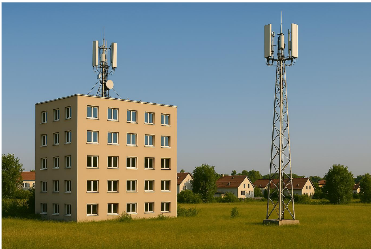
Rysunek 5. Stacje bazowe telefonii komórkowej: zainstalowana na dachu budynku oraz wolnostojąca Źródło: opracowanie własne
